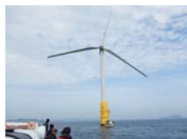
崎山沖 2MW浮体式洋上風力 発電所
