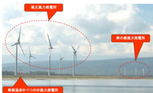
寿都町における風力発電所の様子
