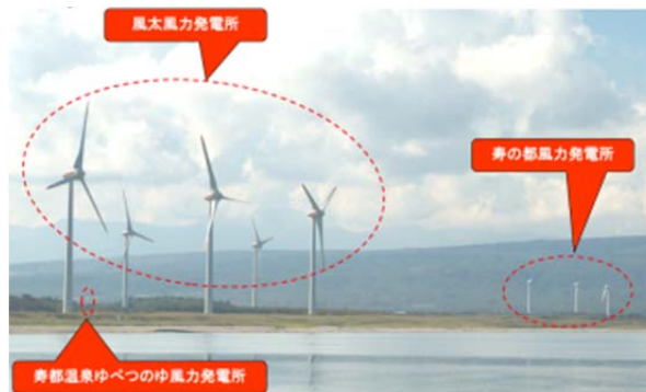
寿都町における風力発電所の様子
