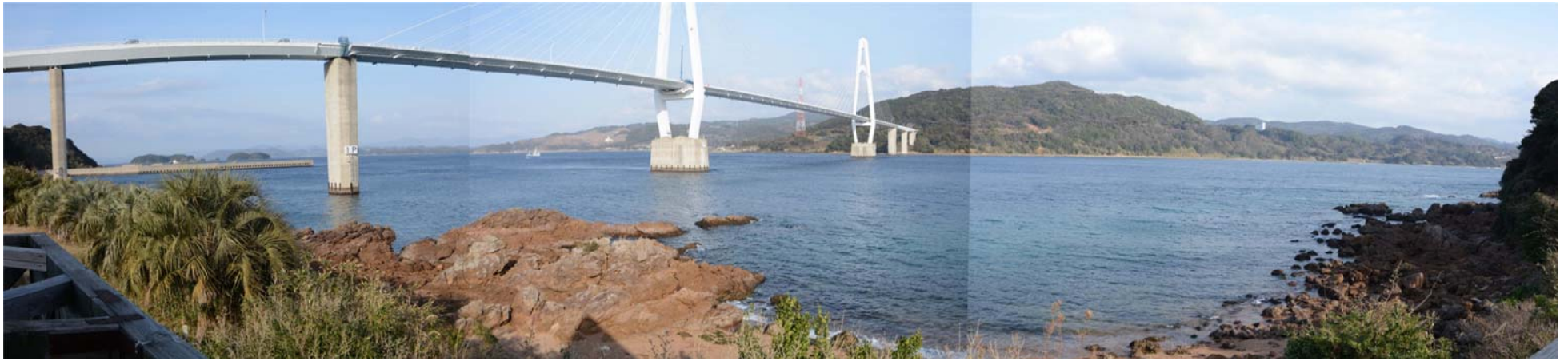
大島大橋公園（北～南）
