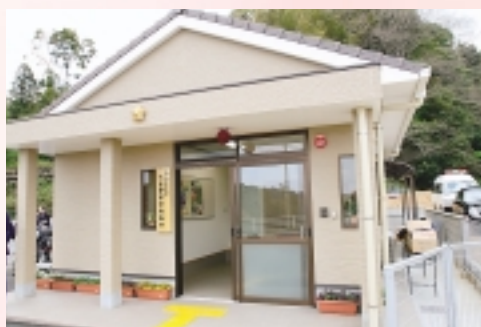
国道沿いに新築された七釜警察官駐在所
