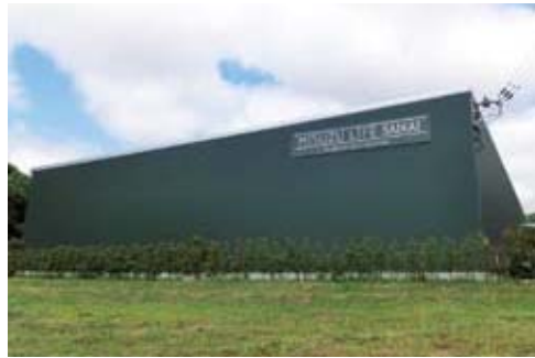
▲自然になじむ外装の西海工場
