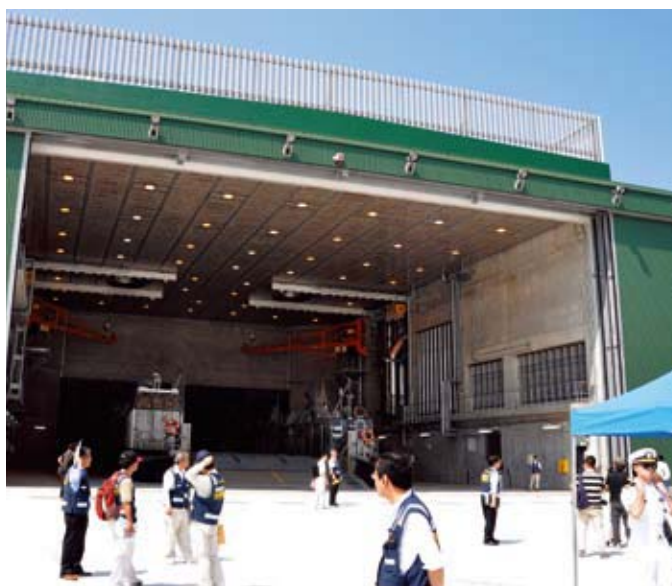
▲ LCAC エンジンテストを行う試運転場（ハッシュハウス）
