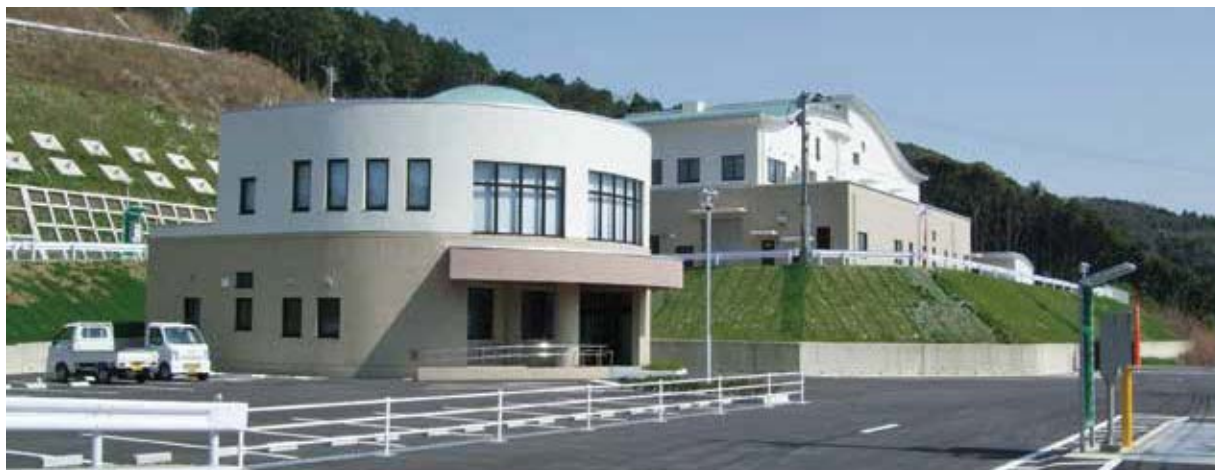
西海市汚泥再生処理センターの全景管理棟(手前)、処理棟(奥)
