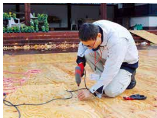
▲施設の修繕作業なども行います
