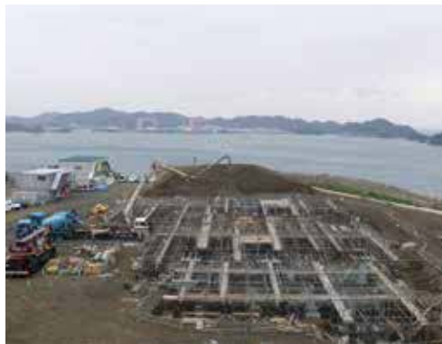
▲着々と工事が進むゴミ処理施設
