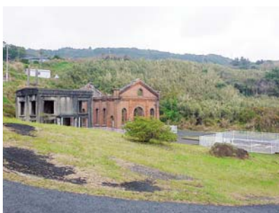
▲松島炭鉱第4坑跡 （平成25年12月撮影）
