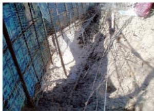
電気線に雑草が接触、支柱ガイシの向きが逆
