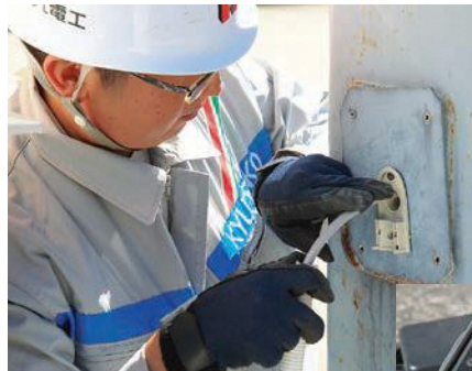
▲施設の漏電修繕作業をする山本さん。工事終了後の点検も丁寧にいきます
