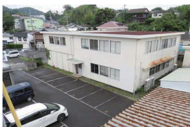
①7月新庁舎建設予定地にあった旧別館等の解体工事が始まりました。
