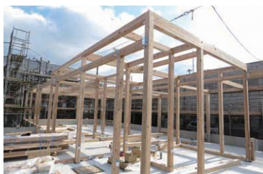
③基礎部分が完成し、12月18日から建物部分の建設工事がスタート。
