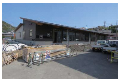
④2月には周囲の足場が外れ新庁舎の全景が姿を現しました。
