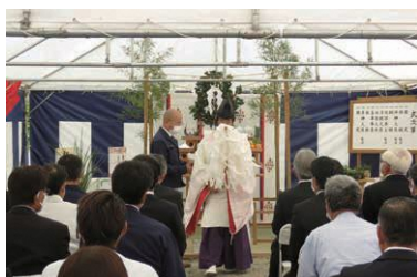
②解体工事が終わり、10月2日安全祈願祭が開催されました。
