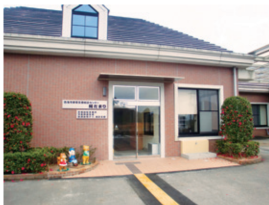
点字ブロック
