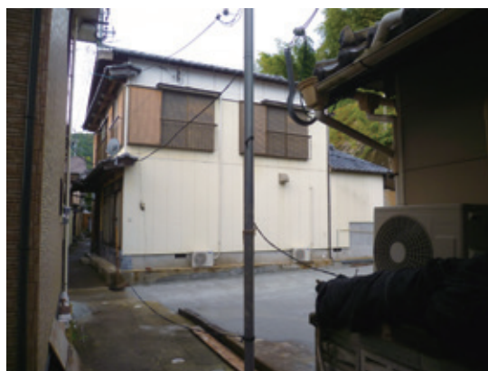
危険空き家の除却後
