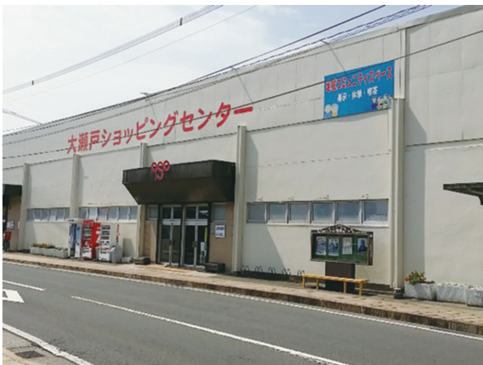
市内大型商業施設
