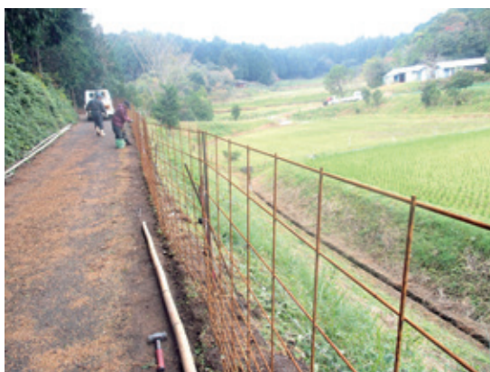
有害鳥獣被害対策：ワイヤーメッシュ柵の設置
