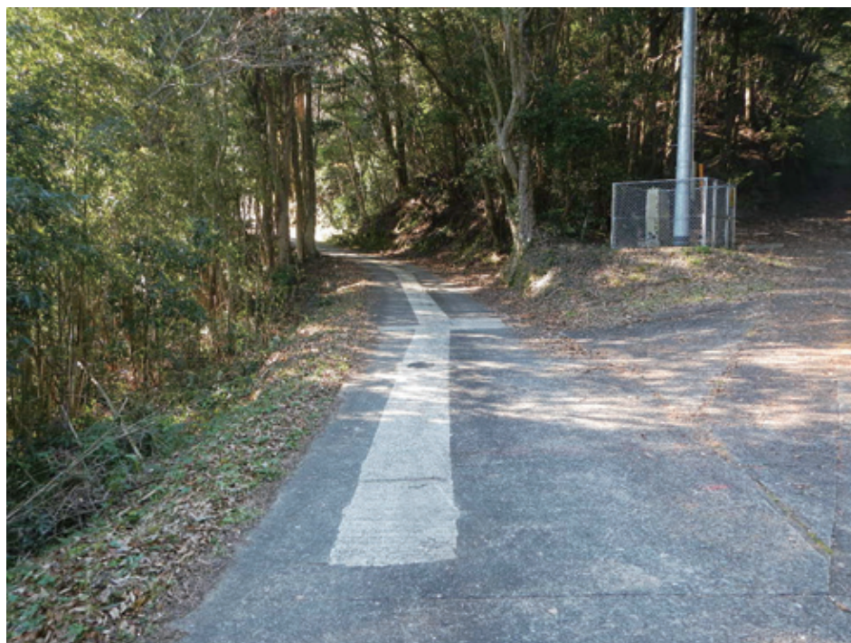
送水(給水) 工事
