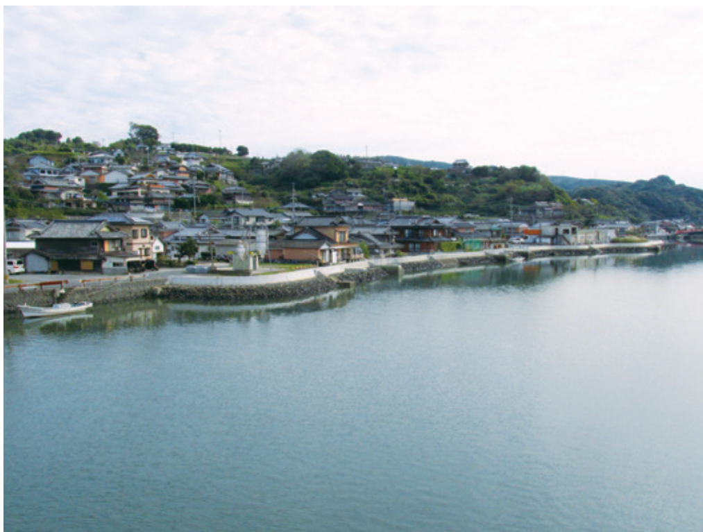
海岸保全事業でかさ上げされた海岸
