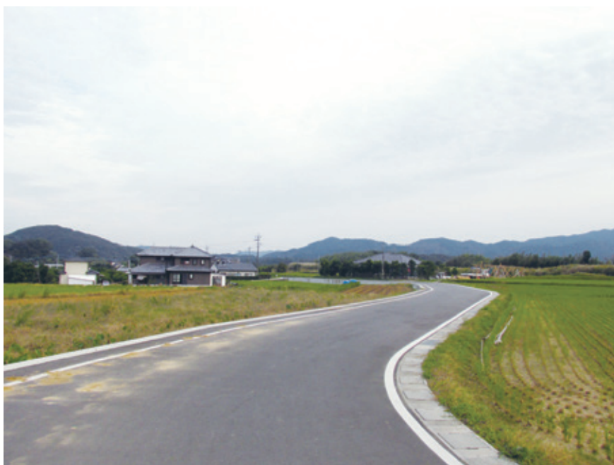
改良が進められた道路
