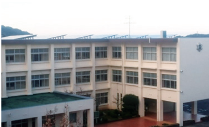
学校施設への太陽光発電設備の導入
