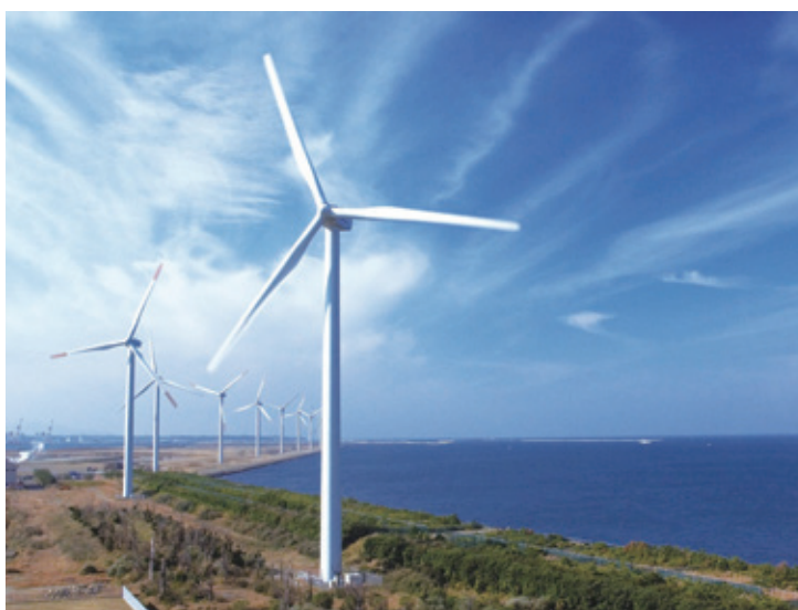
陸上風力発電施設 [写真提供：株式会社エヌエスウインドパワーひびき]
