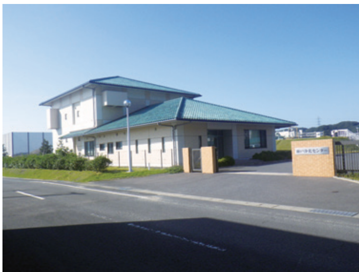
瀬戸浄化センター（大瀬戸町瀬戸板浦郷）
