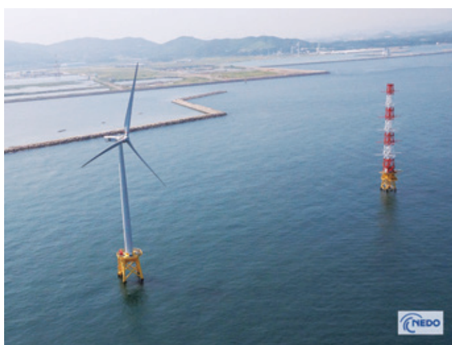
着床式洋上風力発電施設
