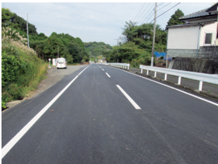
舗装補修で整備された幹線道路
