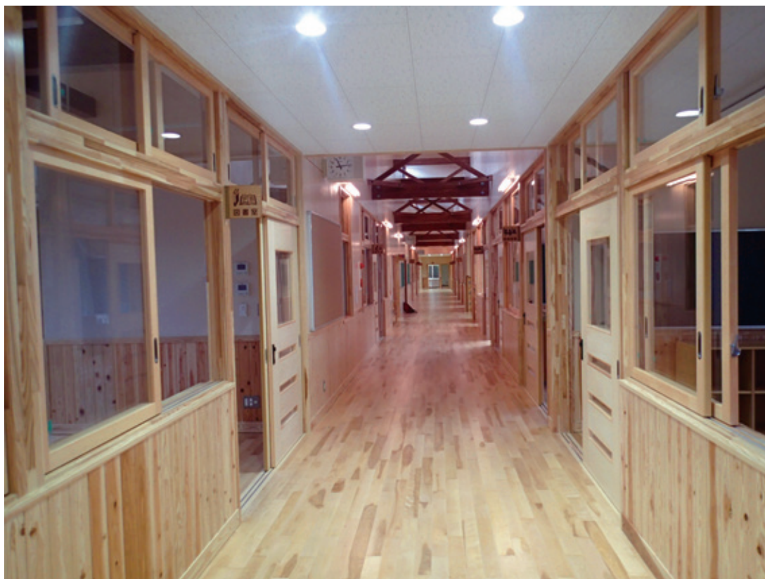
耐震改修事業により改築された江島小中学校校舎
