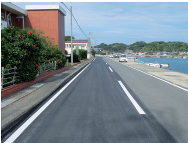
舗装補修で整備された生活道路
