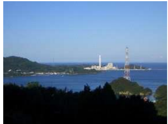
(写真)松島火力発電所
